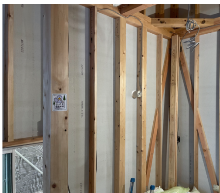
(構造材の様子)
