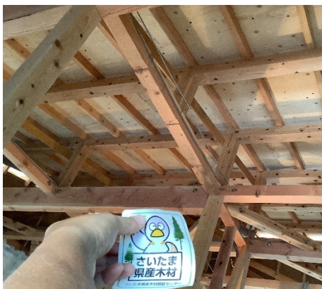
(構造材の様子)
