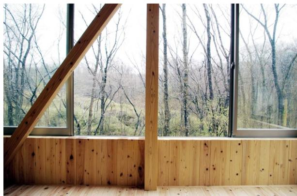
森林環境税などの動きの中で、都市部での木材利用活性化を図りたい。木の構造強度（重量比）と断熱性、燃え代による準耐火性能を活かした利用が重要になる。今回は品川区の不燃化特区での木造 2 階建準耐火構造の中で秩父材の利用を図る事にした。
