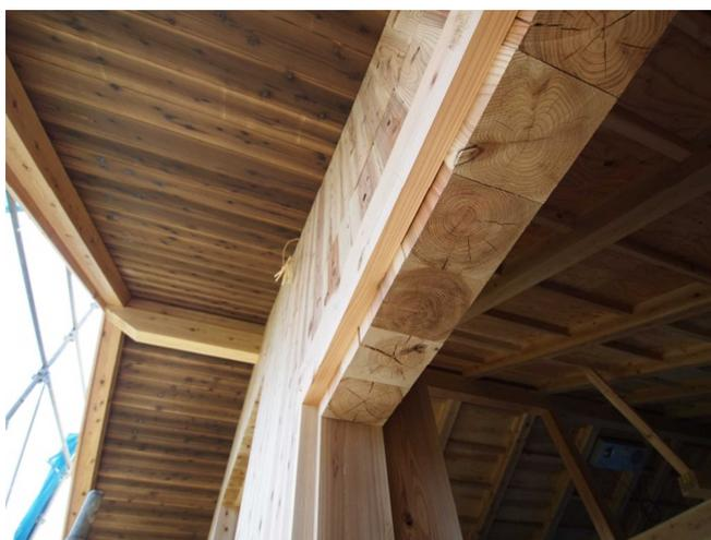
国産材の規格品のB級材の有効利用を目的に、各地の工務店が容易に採用でき、コストもリーズナブルな住宅に採用できるようにしています。木の持つ長所と魅力を表に出して、木にすっぽり包まれた暮らしを提案します。B級材の105角、120角の柱材で家を包み、防耐火性、断熱性も兼ね備えた快適な外壁材（内部は極力現し仕様）とし、予算が許せば、床や野地板にも杉柱をビス止めして集成材とした構造とします。接着による集成材ではない為、糊は一切使用せず、解体すればリユースも可能な、人と環境に優しい工法です。
